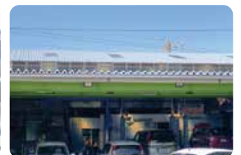
改修後の工場屋根(補助金利用)
